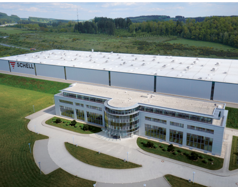
Usine 1 Site de production avec bâtiment administratif et centre de formation
